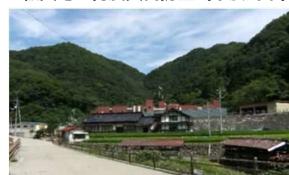
三次市作木支所の保全（三次市）
