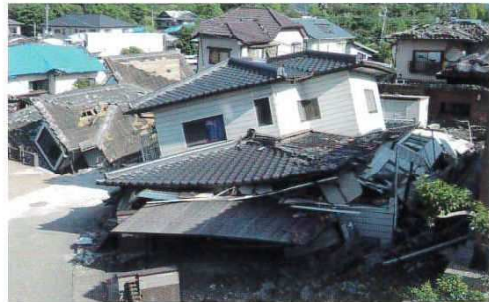
地震による被害例（熊本地震）
