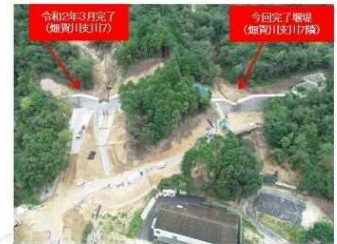
工事完了（令和2年9月18日）
