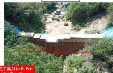
工事完了（令和2年9月18日）
