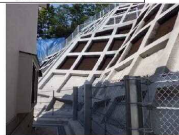
工事完了（令和2年9月11日）
