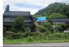
斜面崩壊・被災状況（H30年7月）
