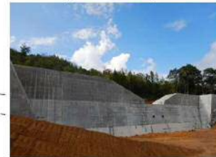
工事完了（令和2年9月30日）
