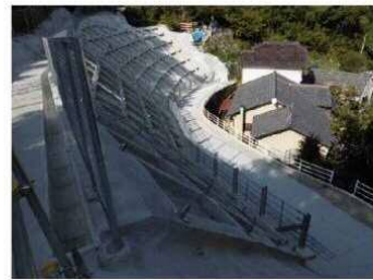
工事完了（令和2年9月30日）
