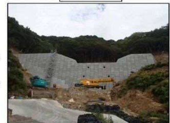
工事完了（令和2年9月18日）
