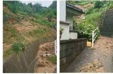
斜面崩壊・被災状況（平成30年7月）
