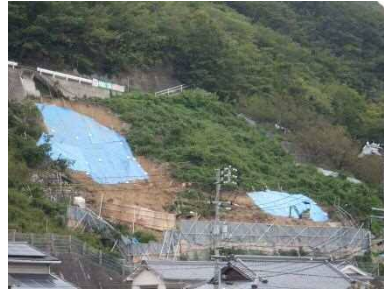
県急傾斜事業 刈浜地区 (呉市蒲刈町)
