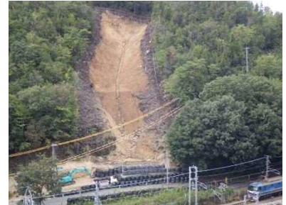
県治山事業 乗重地区 (東広島市志和町)
