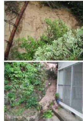
斜面崩壊・被災状況（H30年7月）
