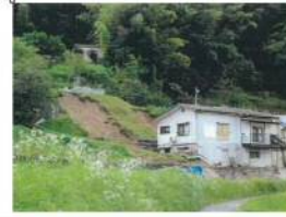
斜面崩壊・被災状況（平成30年8月）
