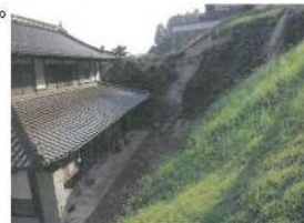
斜面崩壊・被災状況（平成30年8月）
