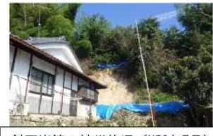
斜面崩壊・被災状況（H30年7月）
