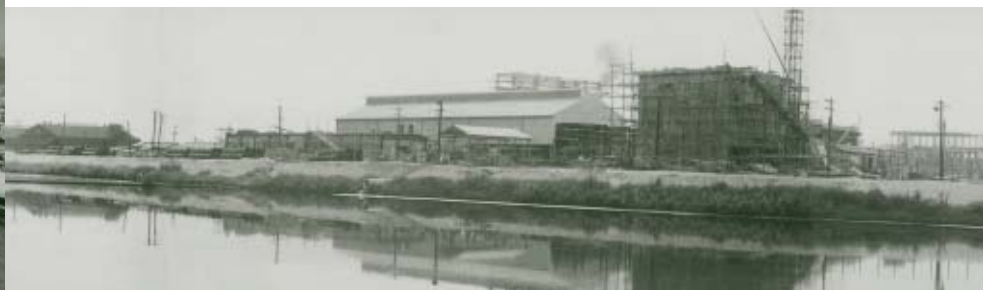
建設中の石油化学工場 昭和36年9月ころ 〔県庁長期保存文書、商工観光課「工場誘致契約及び漁業補償リン議書／三井四社」昭和36年度〕
