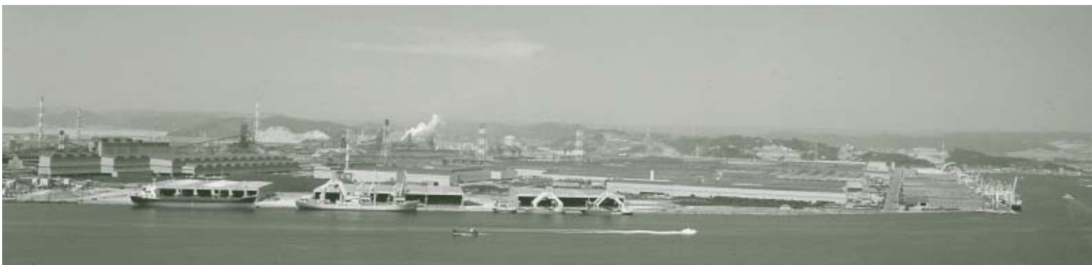
日本鋼管福山製鉄所 昭和52年9月17日 [S05/2002/1460]
