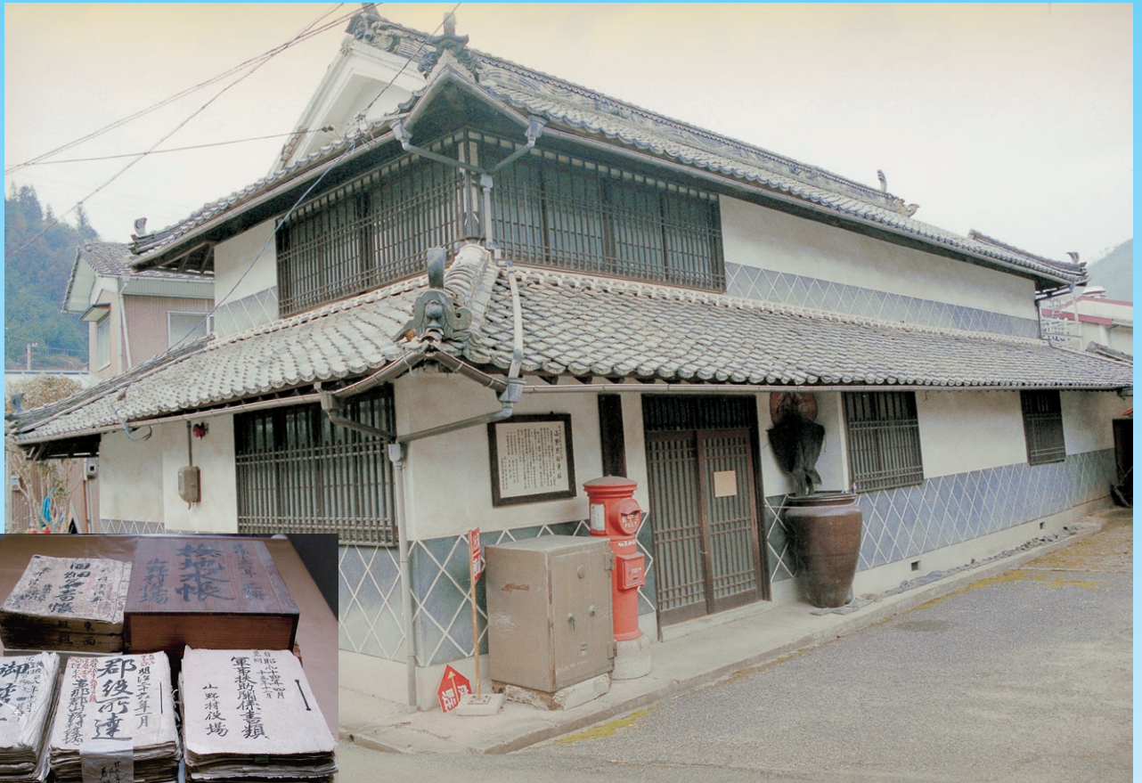
旧山野村役場庁舎 明治25年(1892)建築
