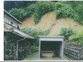
斜面崩壊・被災状況（平成30年8月）
