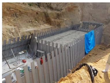
県砂防事業 熊野川支川36隣 (安芸郡熊野町)
