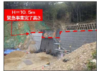
工事完了（令和2年10月15日）
