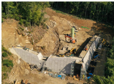
県砂防事業 賀茂川支川7 (竹原市西野町)
