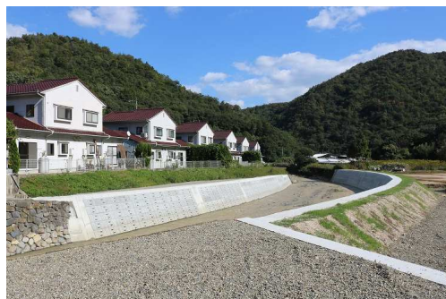
（二）高野川（東広島市安芸津町）
