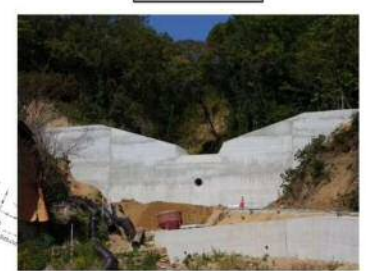
堰堤工事完了（令和2年10月30日）
