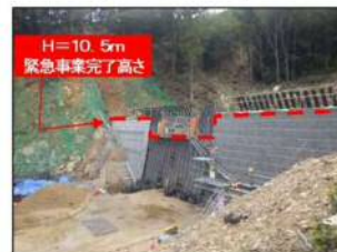
工事完了（令和2年10月15日）
