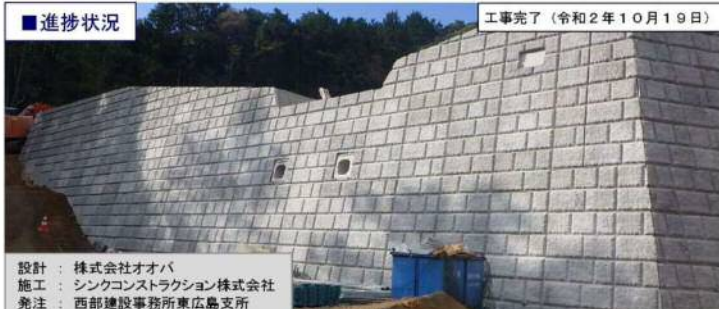
工事完了（令和2年10月19日）
