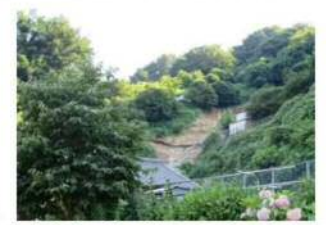
斜面崩壊・被災状況（平成30年7月）
