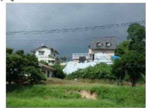
斜面崩壊・被災状況（平成30年8月）
