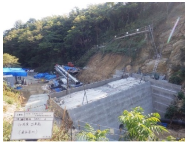
県砂防事業 南永谷川 (尾道市向島町)
