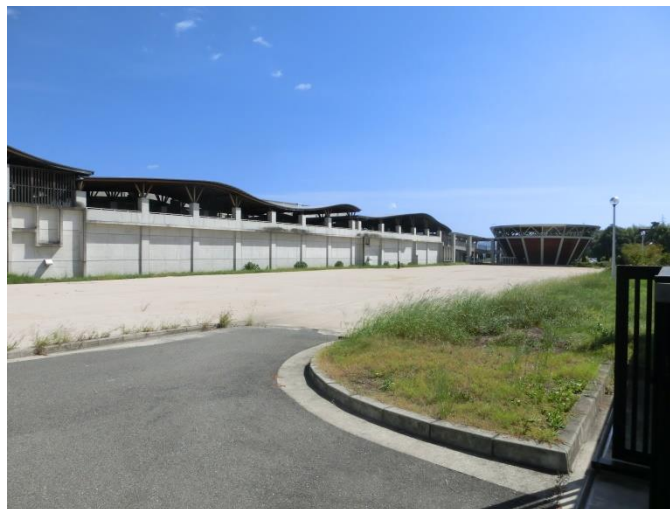
竹原浄化センター（処理完了）
