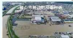
平成30年7月豪雨での被害状況
