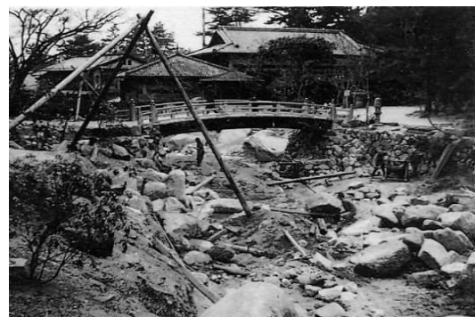
紅葉橋周辺（S20 被災状況）
