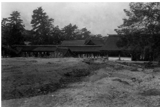
厳島神社の社殿（S20 被災状況）
