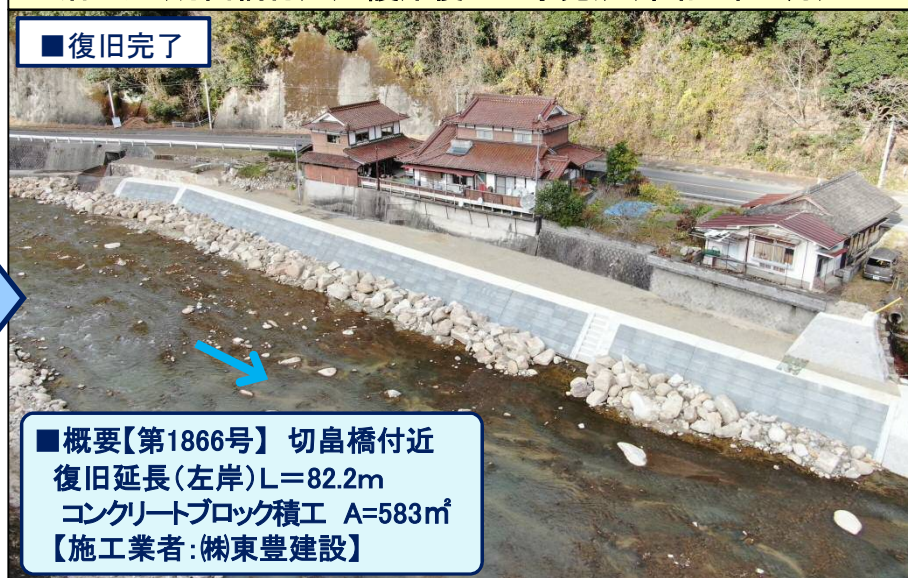
沼田川(切畠橋付近) 護岸復旧工事完成(令和2年11月)
