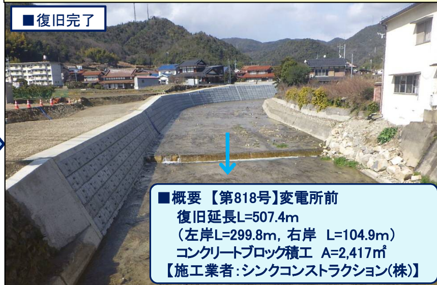
三津大川(変電所前)護岸完成(令和2年12月)
