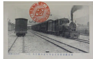
開通式当日の府中駅構内
