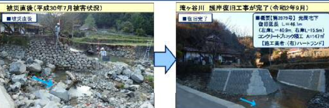
施工：(有)ハートランド
