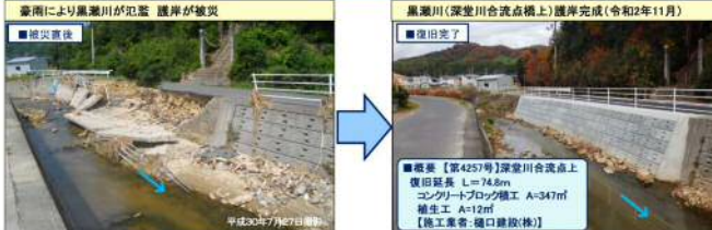
施工：樋口建設(株)
