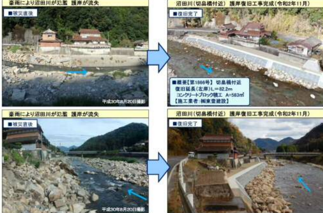
施工：(株)東豊建設
