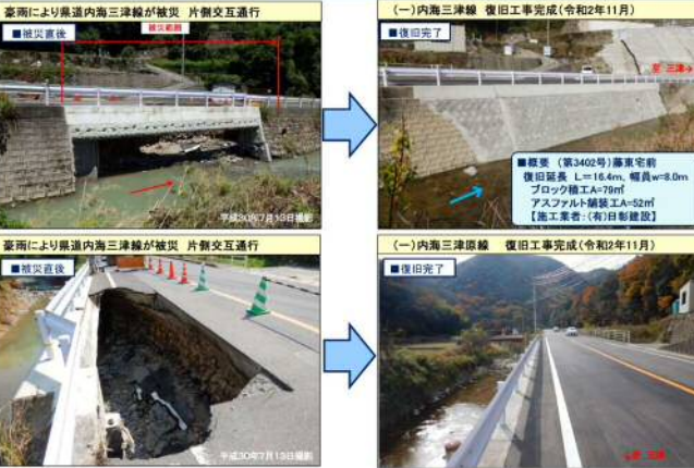
施工：(有)日彰建設
