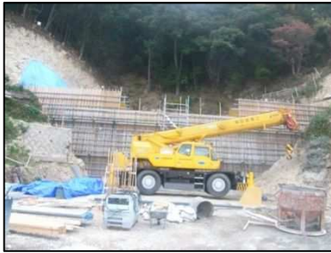
県砂防事業 バイシ川隣 (江田島市江田島町)
