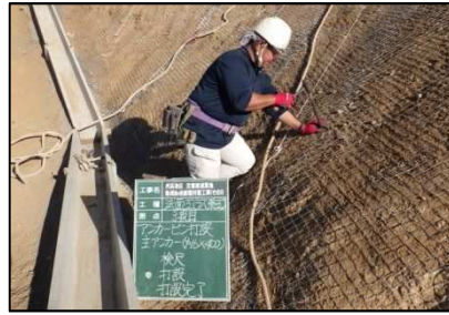
県急傾斜事業 刈浜地区 (呉市蒲刈町)
