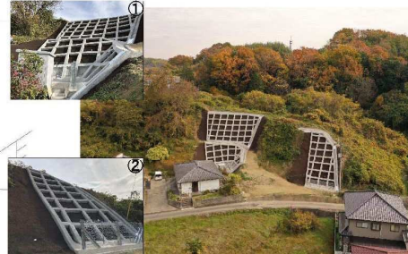
工事完了（令和2年12月9日）
