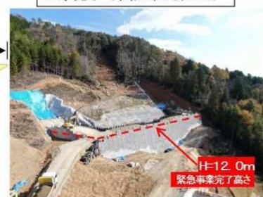
工事完了（令和2年12月11日）
