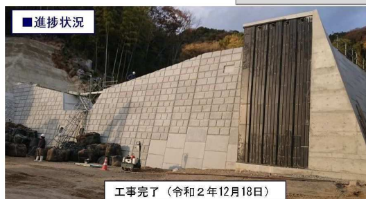
工事完了（令和2年12月18日）
