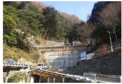
県治山事業 別両路地区 (府中市荒谷町)
