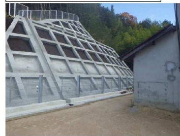
工事完了（令和2年12月3日）
