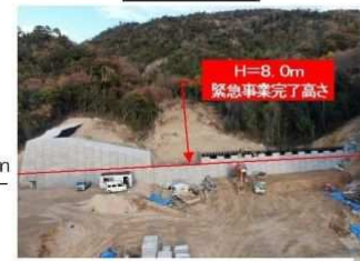
工事完了（令和2年12月1日）
