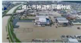
平成30年7月豪雨での被害状況
