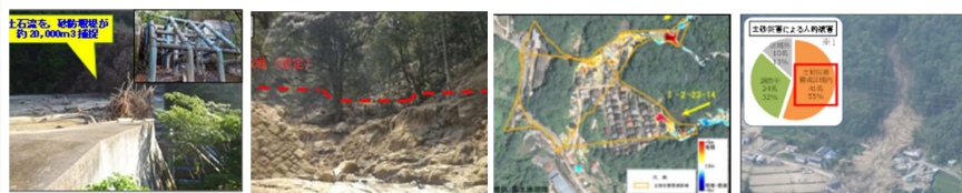
対策施設が効果を発揮 石積砂防堰堤の被災 基礎調査の妥当性を確認 多くが警戒区域内、及び危険箇所で被災
