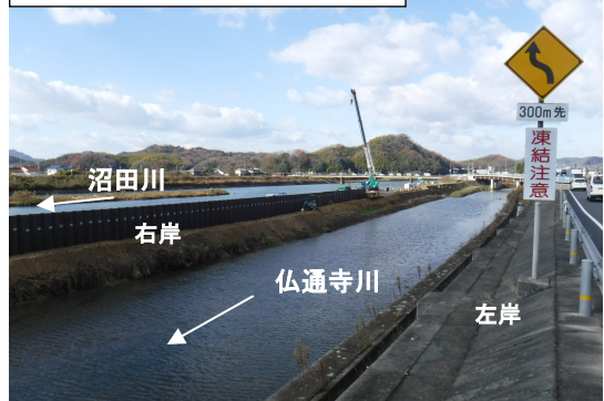
②仏通寺川 (背割堤改築施工状況)
