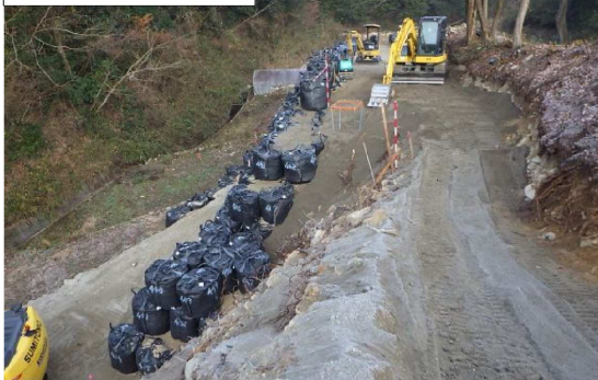
①工事用道路施工状況
