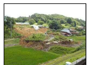
平成30年7月豪雨災害 [神石高原町豊松] (広島県東部農林水産事務所撮影)
