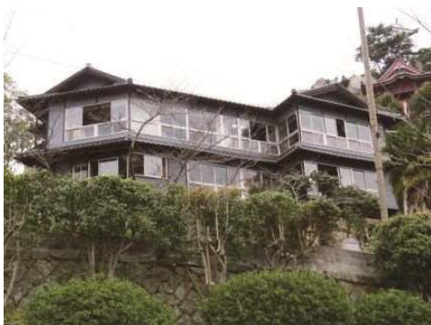
写真 3-9 再生された空き家（尾道市）
