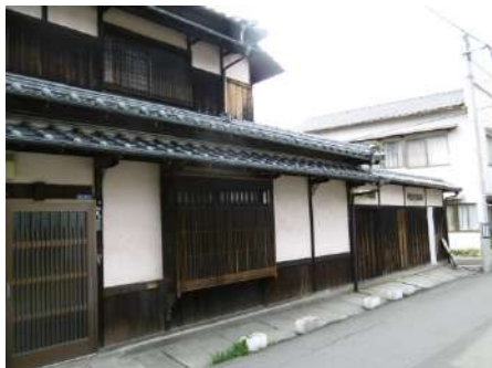
格子や漆喰壁、板塀、和風仕様の玄関扉などの落ち着いたたたずまい
