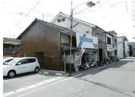
4寸勾配程度の屋根で平入り（手前の2棟）。屋根の勾配が対前えば統一感が高まります
