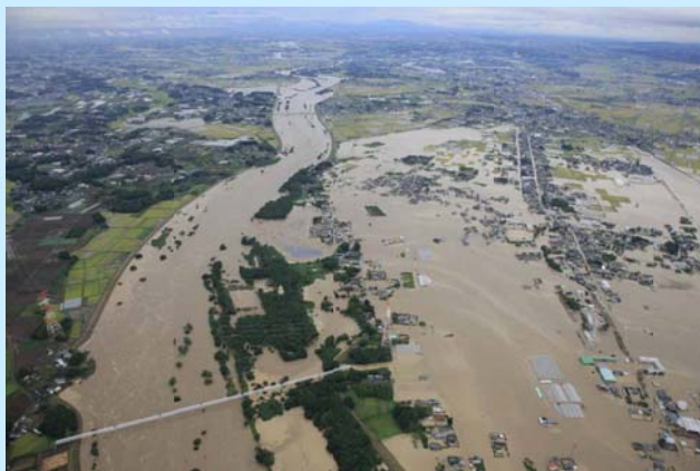
平成 27 年 9 月 鬼怒川（茨城県市常総市） 提供：国土交通省関東地方整備局
