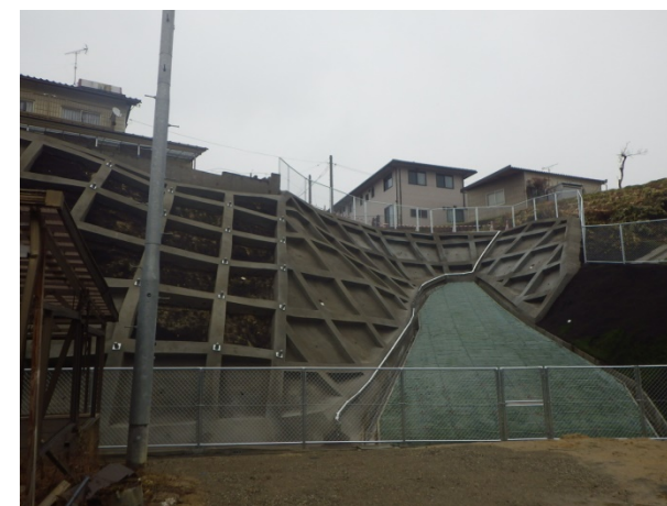
工事完了（令和3年1月26日）
