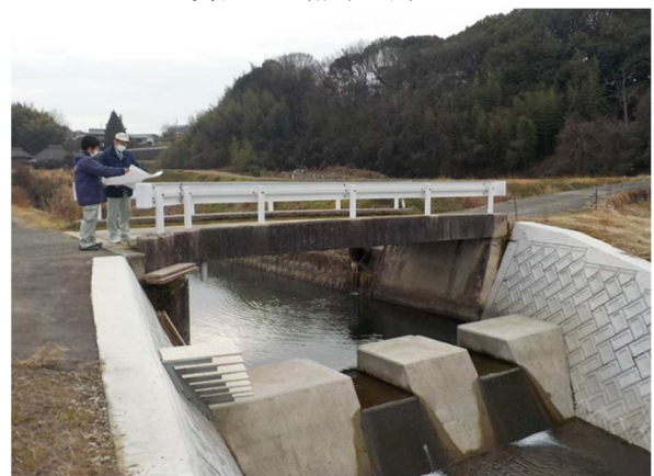
頭首工（福山市）
