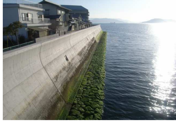
護岸の改良（広島港海岸）
