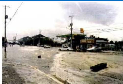
平成 11 年台風 18 号による被害 (広島市江波地区)
