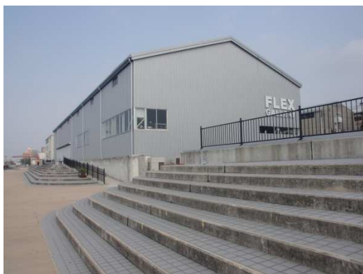
一体的に整備した傾斜護岸（広島港海岸）
