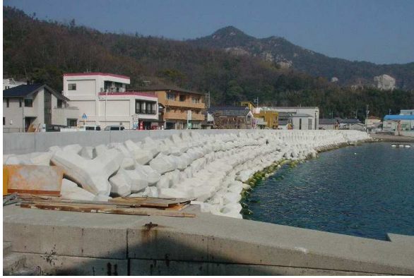
消波ブロックの設置（倉橋漁港海岸）
