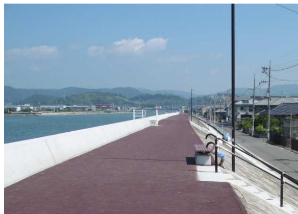
堤防 (尾道系崎港海岸)
