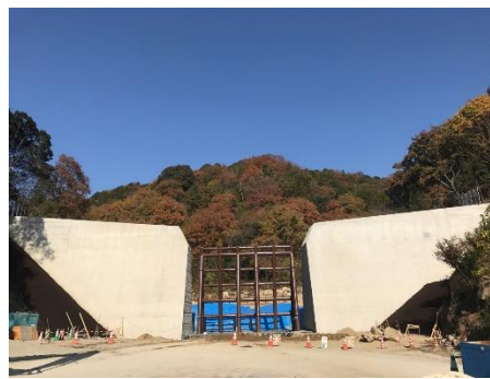
【坂町小屋浦地区砂防堰堤】
