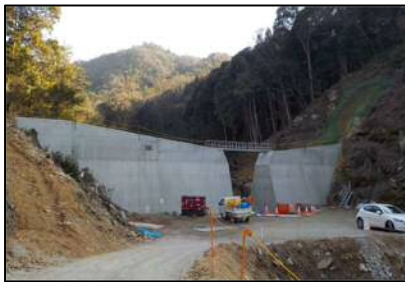
県砂防事業 天地川支川2 (坂町小屋浦)
