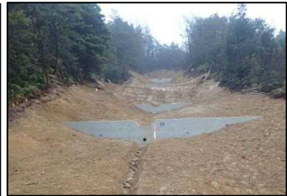
県治山事業 吉川C地区 (東広島市八本松町)
