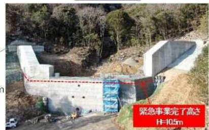
工事完了（令和3年1月29日）
