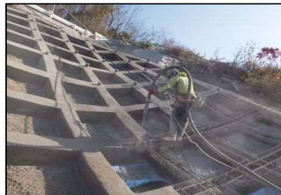
県急傾斜事業 刈浜地区 (呉市蒲刈町)
