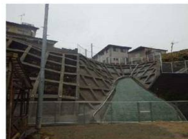
工事完了（令和3年1月26日）
