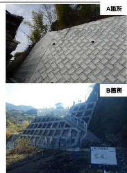
工事完了（令和3年1月29日）
