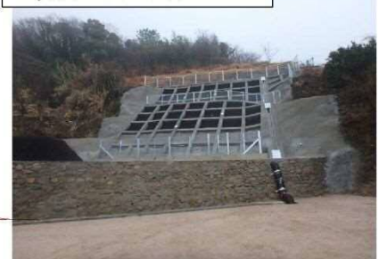
工事完了（令和3年1月25日）
