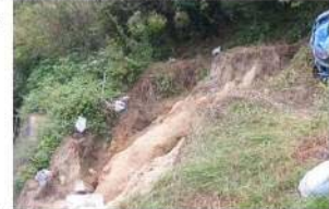
斜面崩壊・被災状況（H30年7月）
