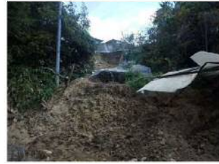
斜面崩壊・被災状況（平成30年8月）
