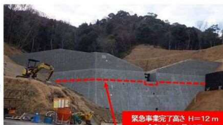
緊急事業完了高さ H=12 m 令和2年11月16日
