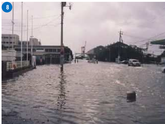
広島港海岸中央西地区
