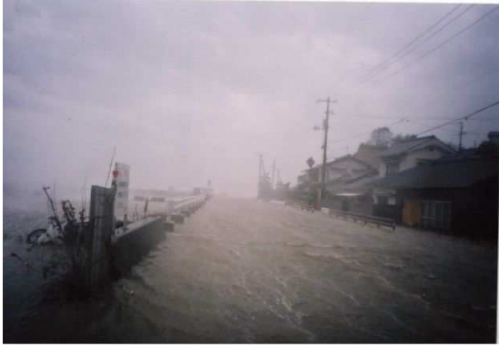
H16 台風 18 号による被害（尾道糸崎港海岸）
