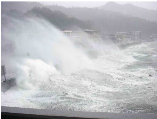
H16 台風 18 号による被害（倉橋漁港海岸）
