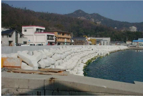
消波ブロックの設置（倉橋漁港海岸）
