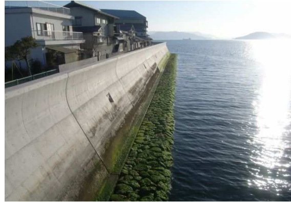
護岸の改良（広島港海岸）
