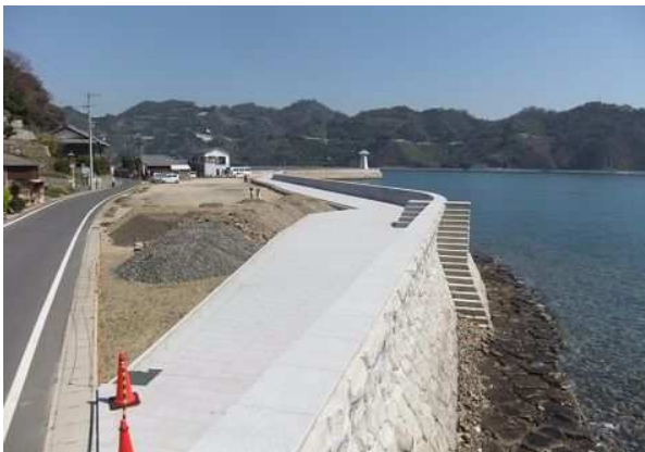
護岸 (御手洗港海岸)
