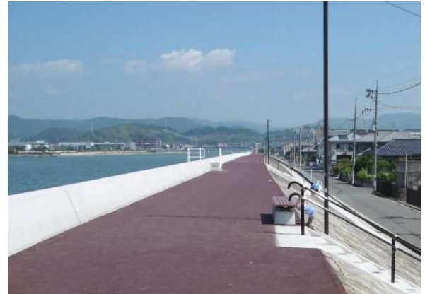
堤防 (尾道糸崎港海岸)
