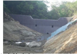
打ち増し工法による改築事例
