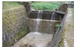
水叩工による洗堀対策
