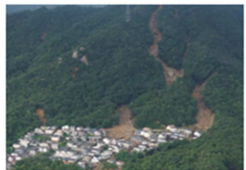
二河川支川21隣(熊野町)
