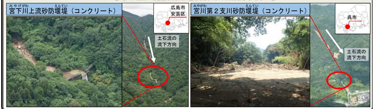
平成30年7月豪雨では、広島県で30箇所以上の砂防堰堤が土石流を捕捉し、事前防災対策の効果が着実に発揮されました。
