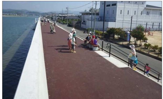
尾道糸崎港海岸堤防
