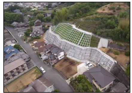
急傾斜地崩壊対策事業 (福山市 野々浜地区)
