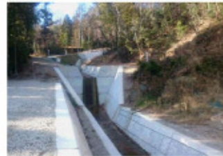
写真-1 護岸工および床固工
