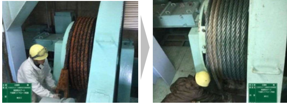
写真-1 修繕写真(ゲートワイヤーロープ)
