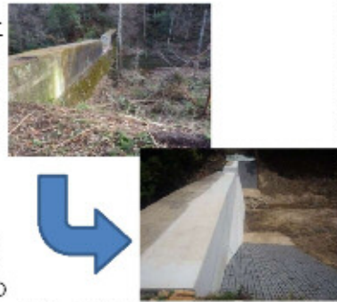
写真-1 砂防堰堤の修繕事例（三原市）
