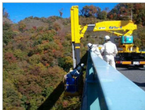
【橋梁点検車による施設点検の実施状況】
