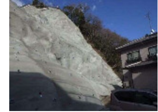
施工後 (繊維補強モルタル吹付後)
