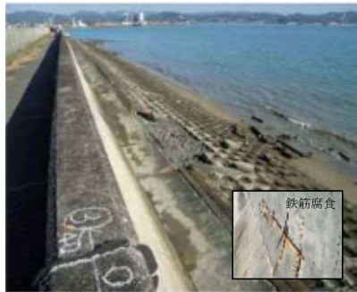
写真-1 健全度1の施設の修繕事例
