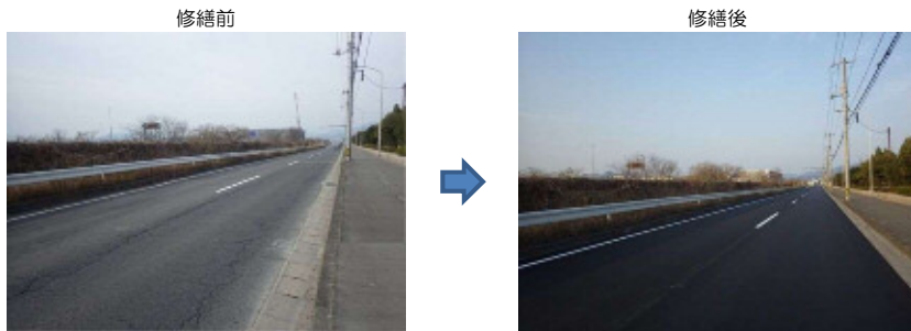
写真1 臨港交通施設の修繕事例
