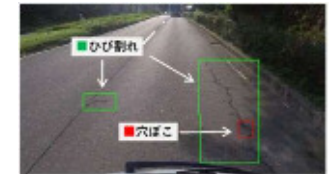
図-4 ドライブレコーダーにより取得した画像のAI解析イメージ
