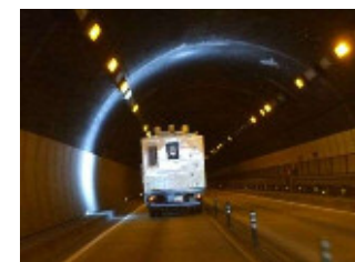
写真-1 走行型計測車両による画像撮影事例
