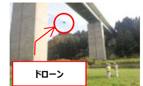
写真-1 ドローンによる点検
