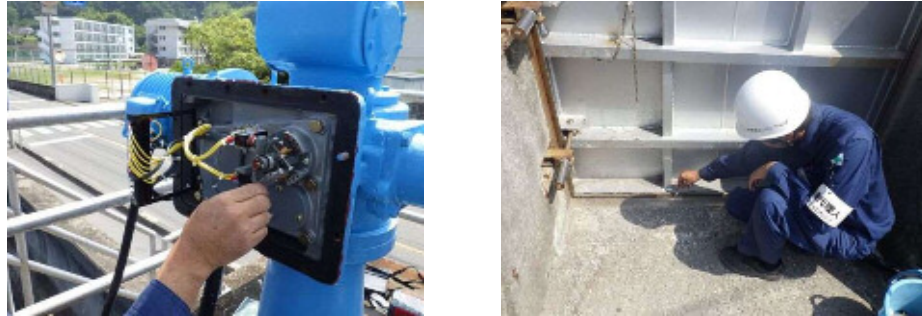
写真-1 健全度1の施設の修繕事例
