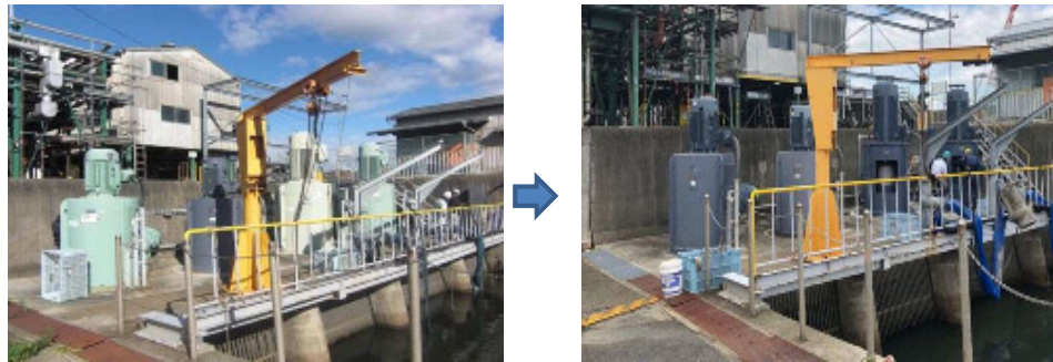
写真-1 健全度1の施設の修繕事例
