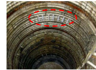
施工後 (集水パイプの追加)
