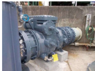
写真-2 吐出弁・逆流弁
