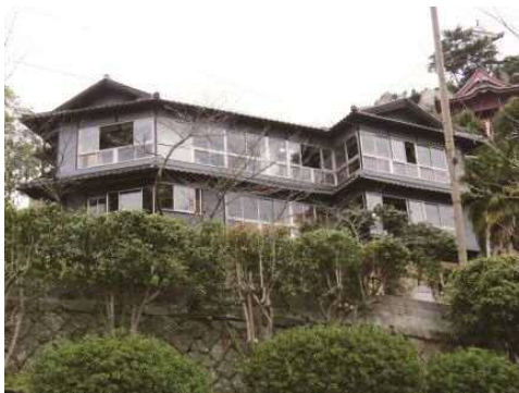
写真 3-9 再生された空き家(尾道市)
