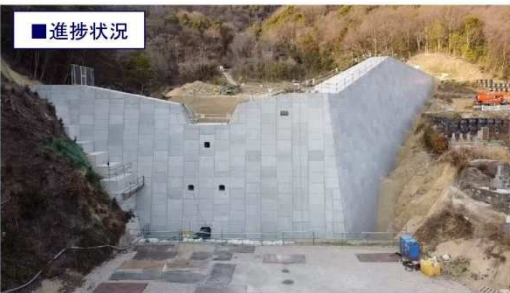
工事完了（令和3年2月26日）
