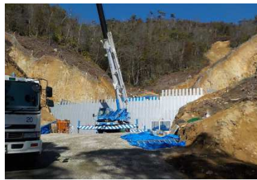
県砂防事業 熊野川支川11 (熊野町新宮)
