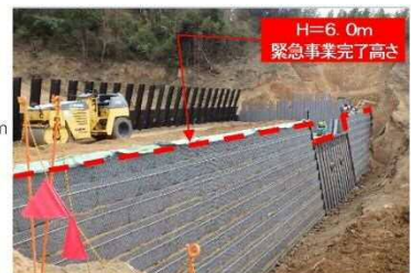
工事完了（令和3年2月26日）
