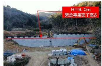
工事完了（令和3年2月15日）
