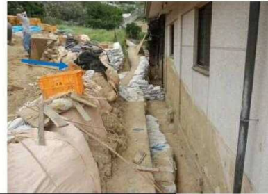
工事完了（令和3年2月4日）
