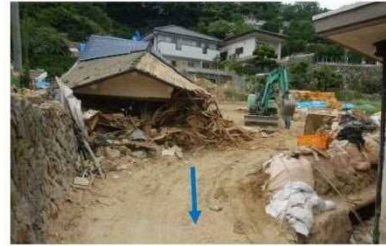
斜面崩壊・被災状況（H30年7月）
