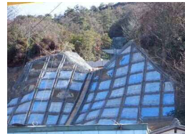
県治山事業 小宇和木地区 (呉市倉橋町)
