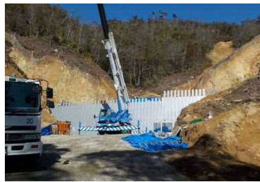
県砂防事業 熊野川支川11 (熊野町新宮)
