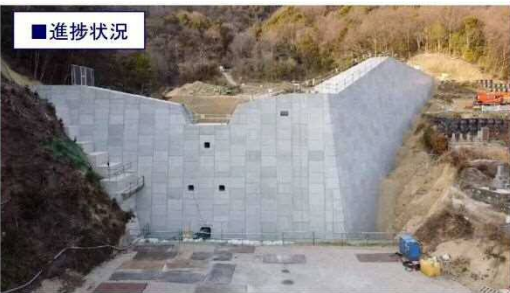
工事完了（令和3年2月26日）
