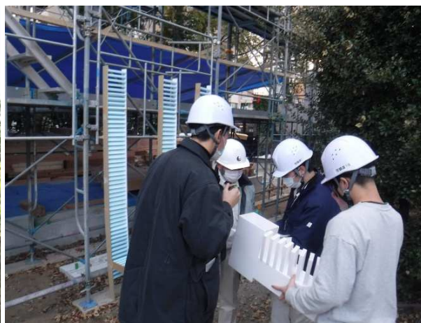
学生も参画した工事打合せの様子
