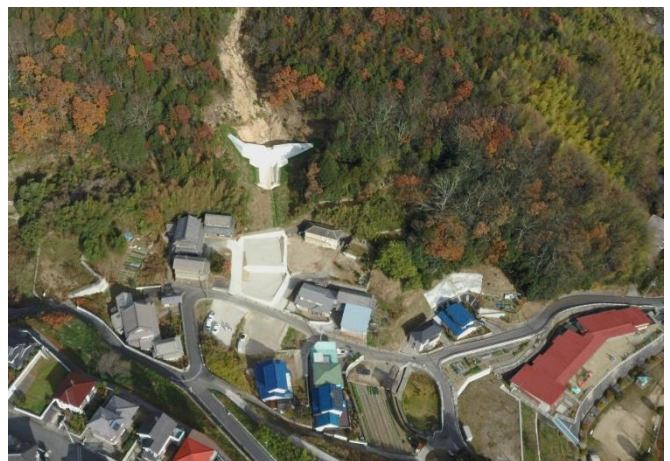
【図4 災害地の復旧状況（福山市神村町）】
