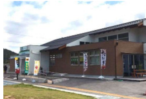
写真 3-2 三次市川西地区の地域生活交流施設
