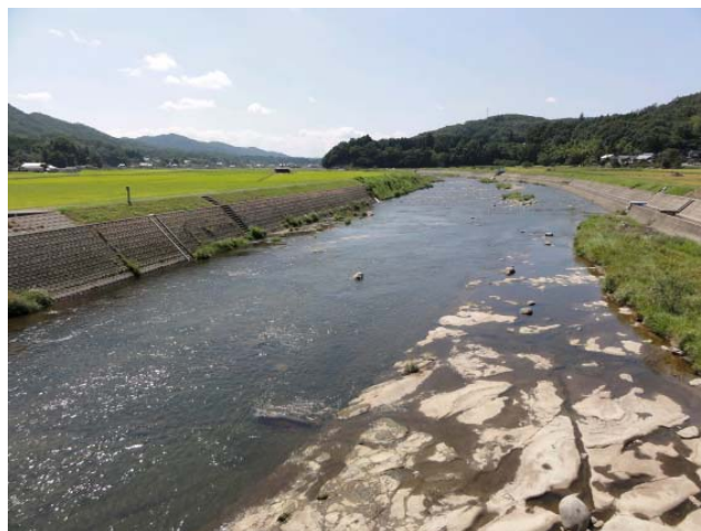
西城川における河床部の岩露出状況
