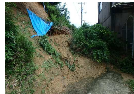
斜面崩壊・被災状況（H30年7月）
