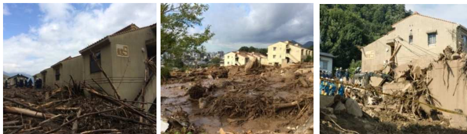
【写真】 県営緑丘住宅被災状況
