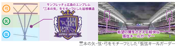
三本の矢・弦・弓をモチーフとした「張弦キールガーダー」
