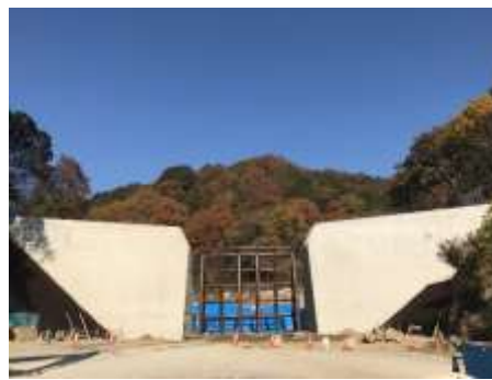
【坂町小屋浦地区砂防堰堤】
