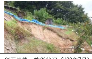
斜面崩壊・被災状況（H30年7月）
