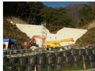
工事完了（令和3年3月5日）
