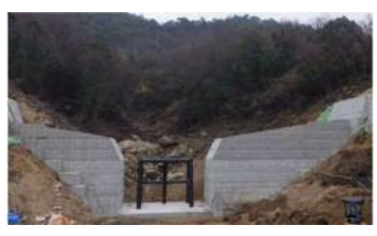
工事完了（令和3年3月17日）
