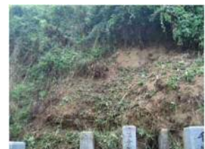
斜面崩壊・被災状況（H30年7月）
