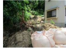
斜面崩壊・被災状況（H30年7月）
