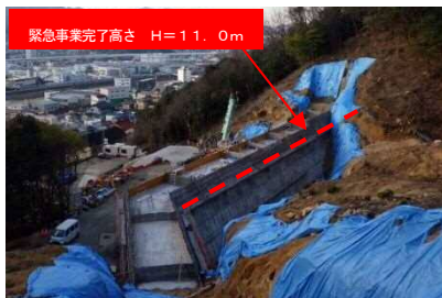
県砂防激特事業 楠木谷川 (海田町畝2丁目)
