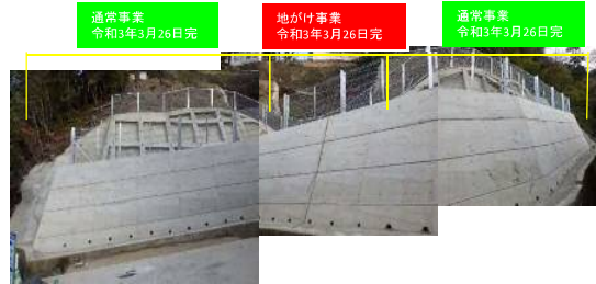
工事完了（令和3年3月26日）
