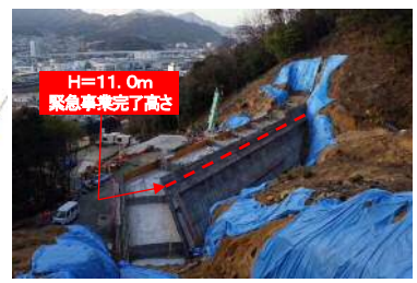
工事完了（令和3年3月12日）
