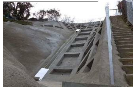
工事完了（令和3年3月18日）
