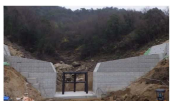
工事完了（令和3年3月17日）
