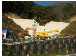
工事完了（令和3年3月5日）
