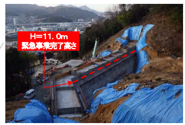
工事完了（令和3年3月12日）
