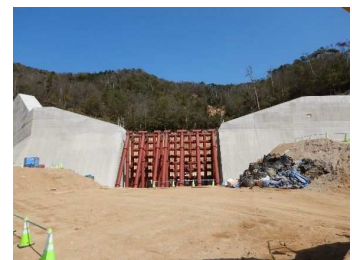
工事完了（令和3年3月29日）
