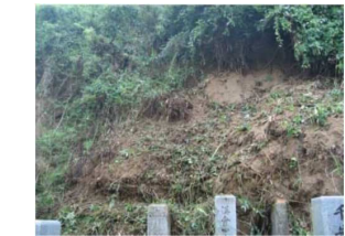
斜面崩壊・被災状況（H30年7月）
