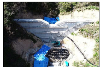
工事完了（令和3年3月25日）
