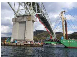
橋脚耐震補強工事状況
