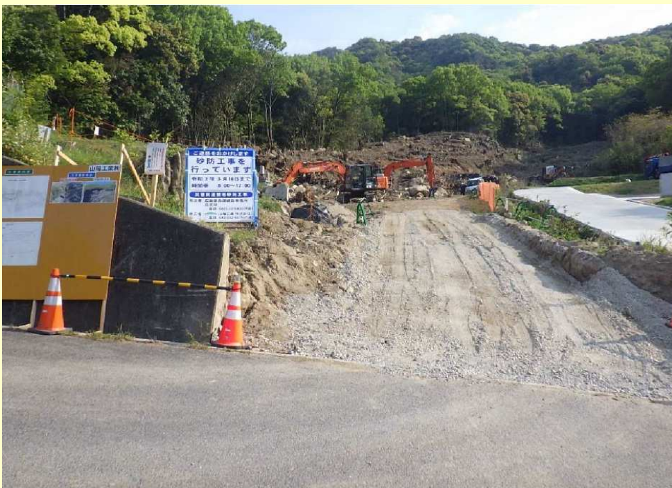
工事用道路工(R2.4月末時点)
