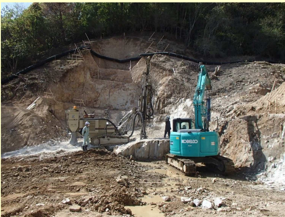
掘削工(R2.4月末時点)
