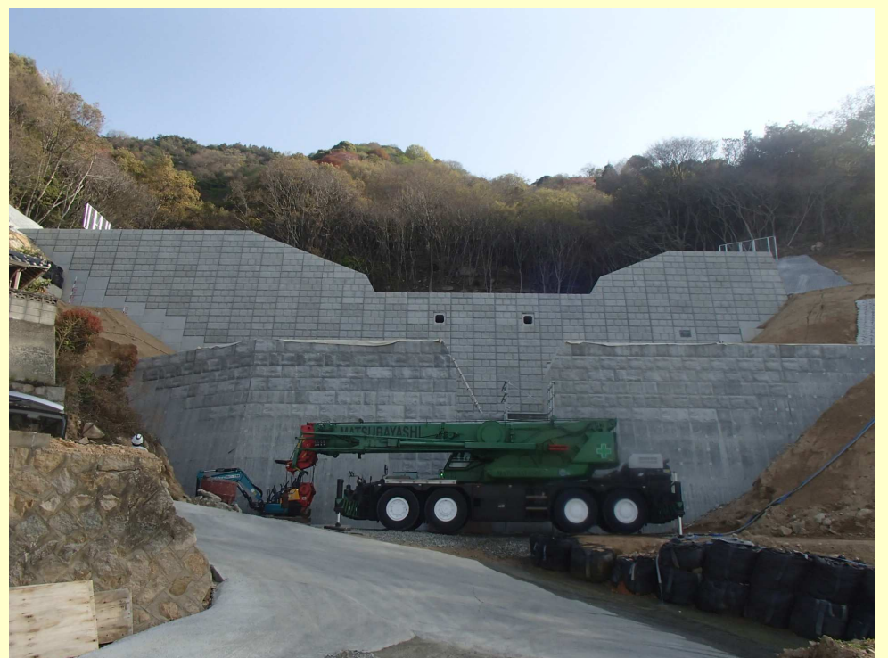
側壁護岸工(R3.3月末時点)
